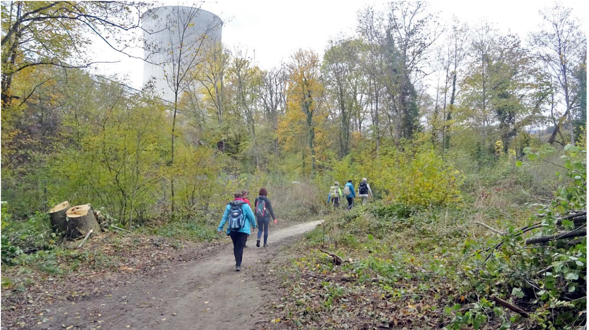
Passage entlang dem Areal des KKW Gösgen
