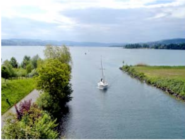
Damm-Kanal mit Sicht Richtung Zürichsee
