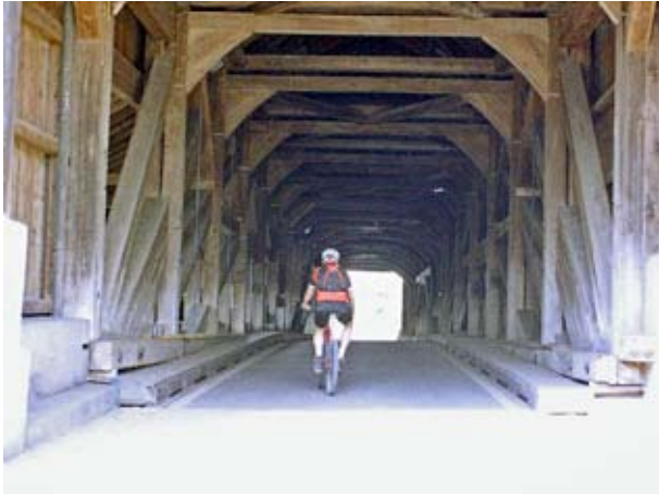
Überqueren der Reuss über die geschichtsträchtige Zollbrücke Sins
