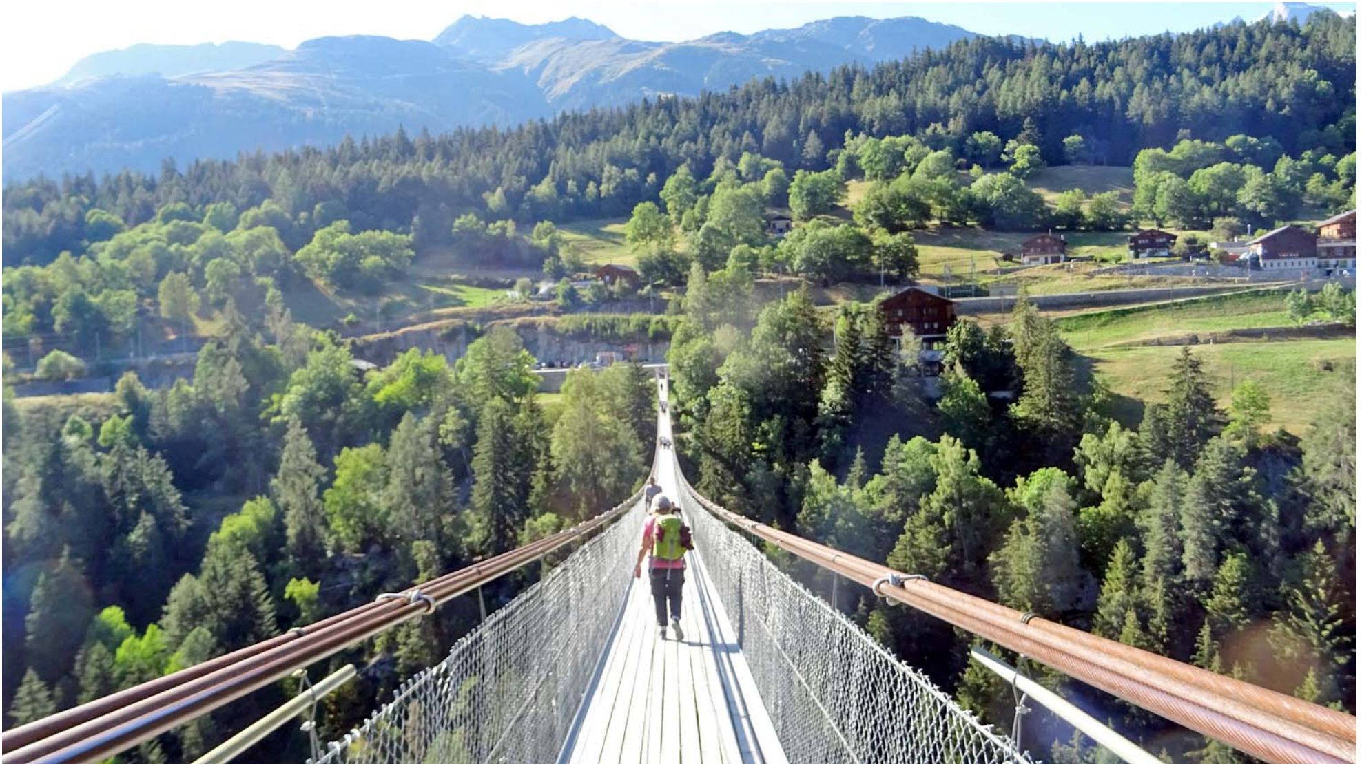
Begehung der 280 m langen «Goms Bridge», hier aus der Mühlebach-Perspektive
