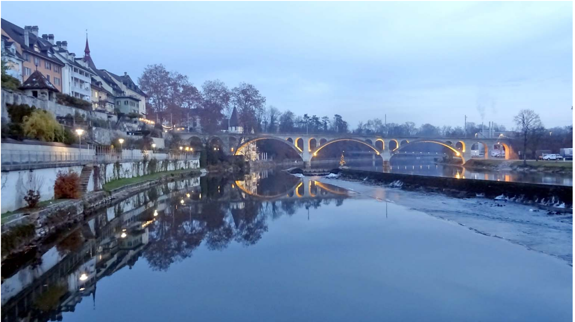
Blick auf das dezent beleuchtete Viadukt der Mutschellenbahn (S17)
