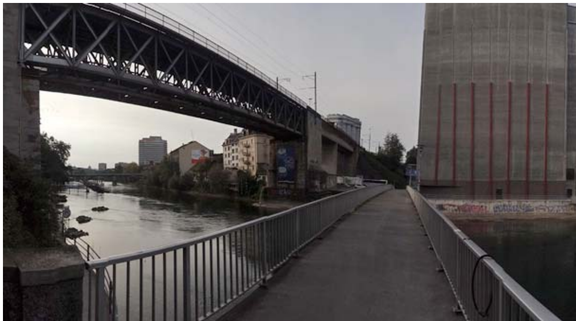
Bahn-Viadukt bei Zürich-Wipkingen:
