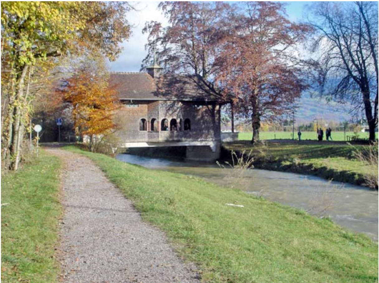
Die Aabachbrücke aus der Nordsicht
