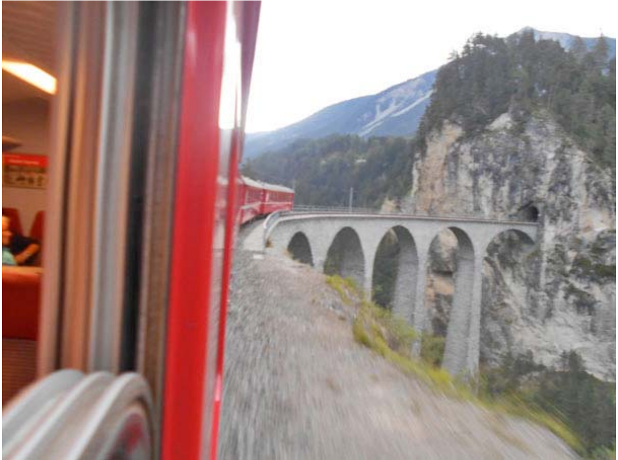
Blick aus dem (geöffneten) Zugsfenster auf das Landwasser-Viadukt
