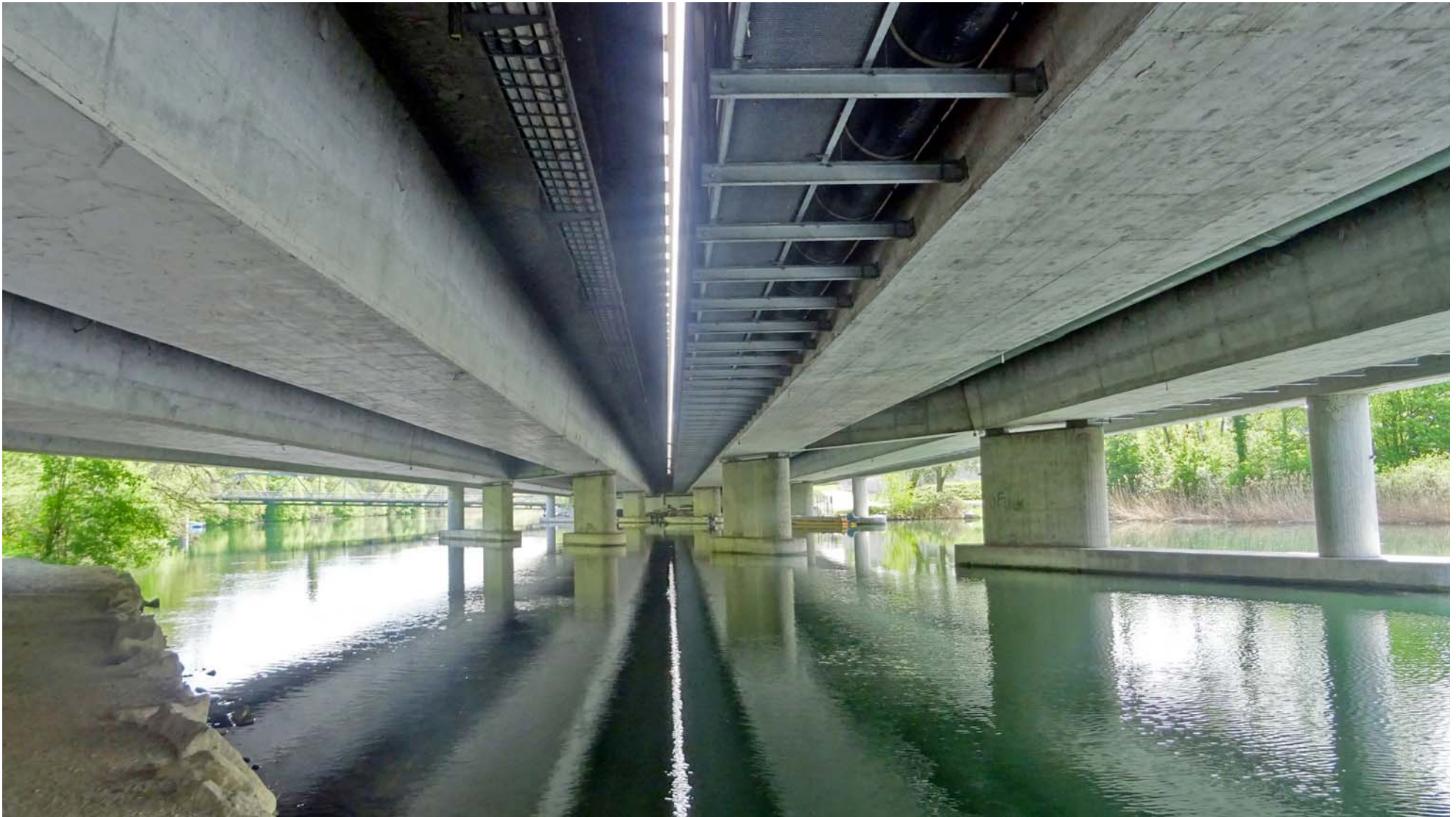
Unterquerung der A1-Autobahnbrücke
